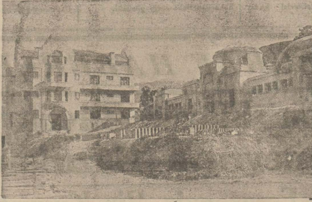
Bursada yeni yapılan otel ve kaplıca binaları
